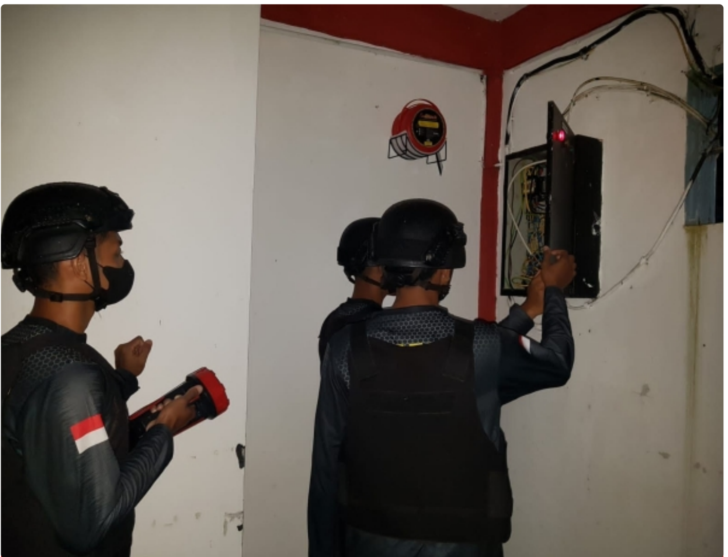
Petugas Lapas Pasir Putih melakukan pengecekan jaringan listrik dan cctv
