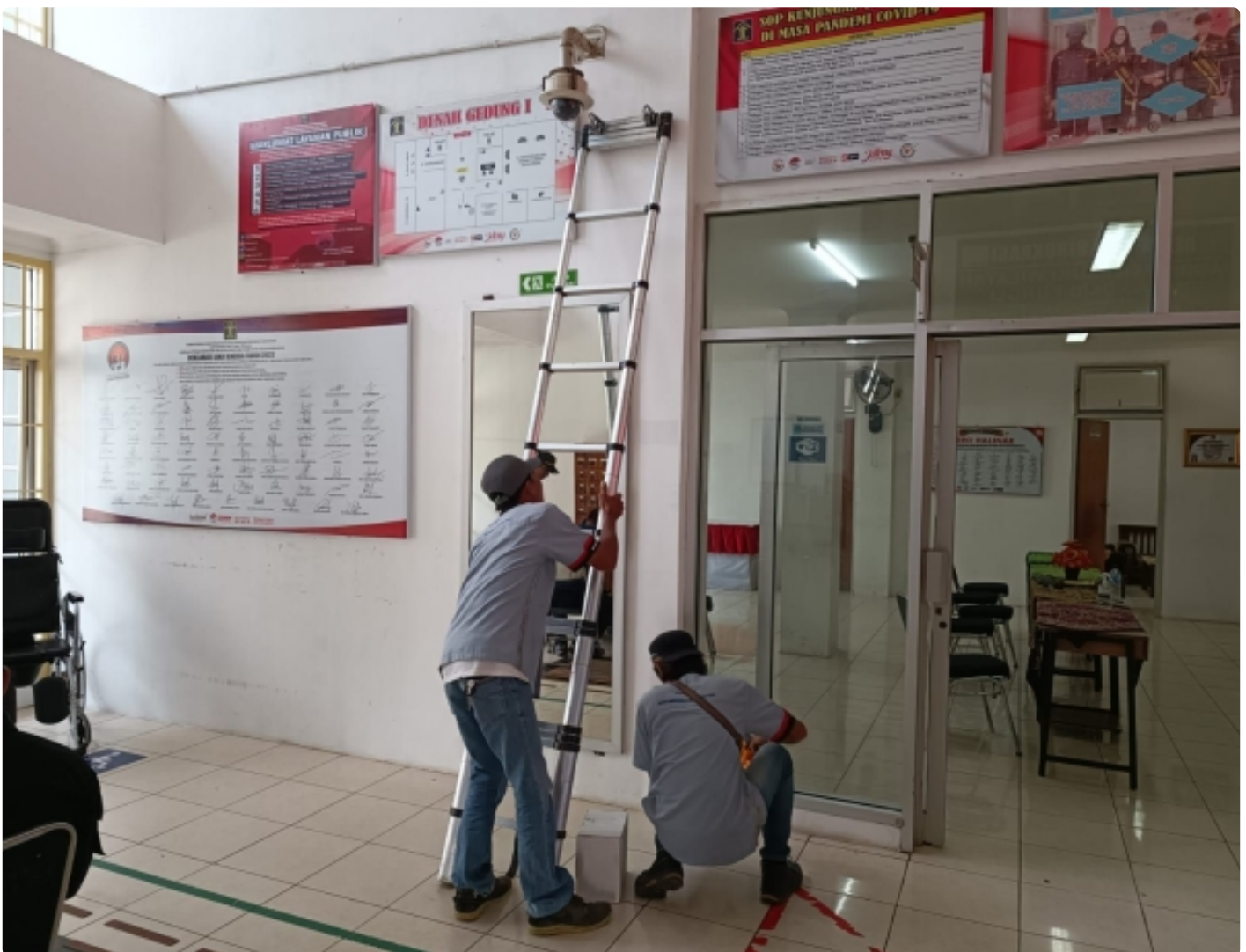
Teknisi khusus operator dari Icon lakukan perawatan pada CCTV Lapas Pasir Putih
